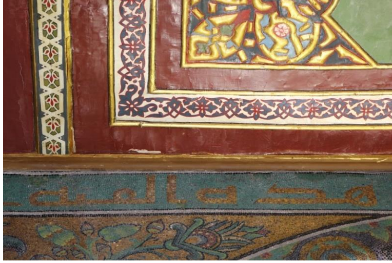
Resim 1. Kubbetü's-Sahra, Kubbetü's-Sahra, Emevî kitâbesi, dış revak kemer doğu cephesi
